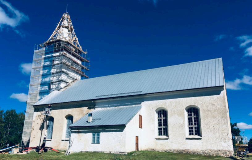
Käib kiriku külgfassaadi puhastamine survepesuriga.
